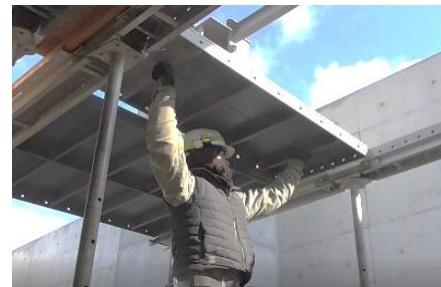
写真－2 アルミ型枠工法 1)
