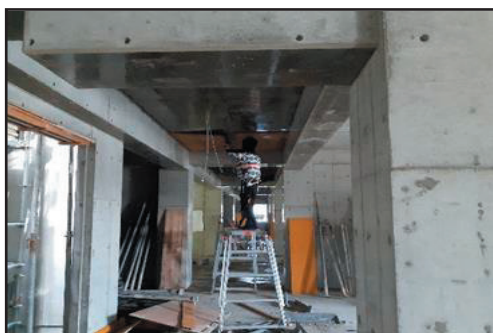
写真3 スラブ型枠解体（従来型枠工法）の作業状況
