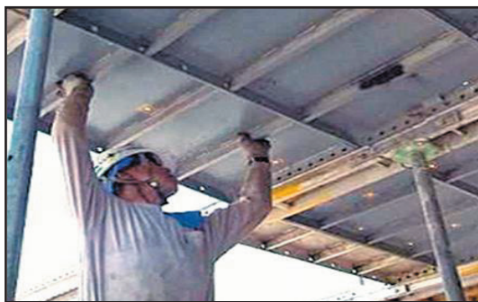
写真2 アルミ型枠工法
