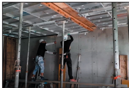
写真4 スラブ型枠解体（アルミ型枠工法）の作業状況
