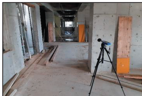
写真5 スラブ型枠解体作業の騒音測定状況
